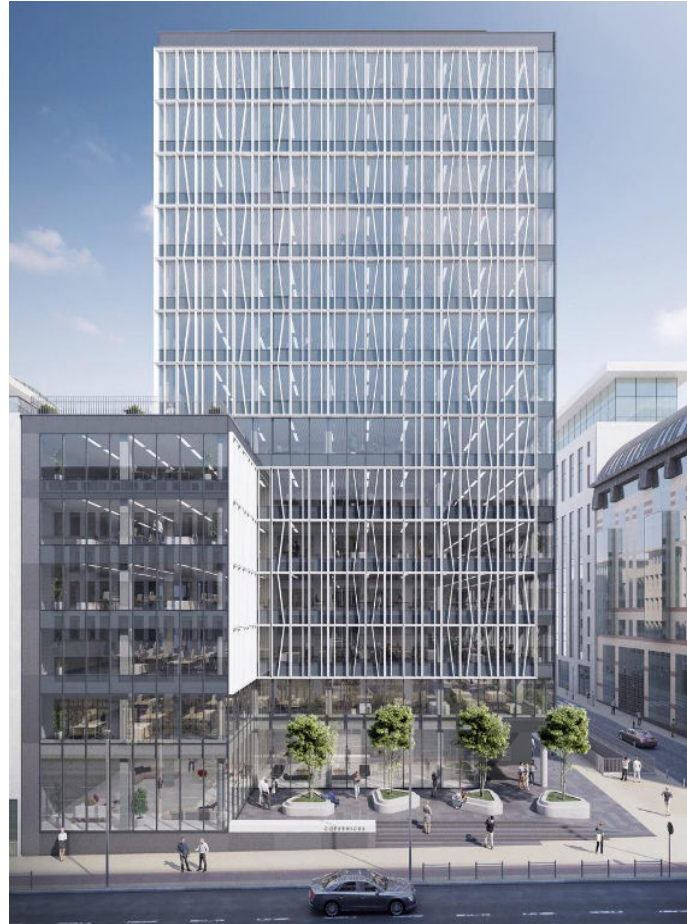
Immeuble Alides, LD2, 2020
