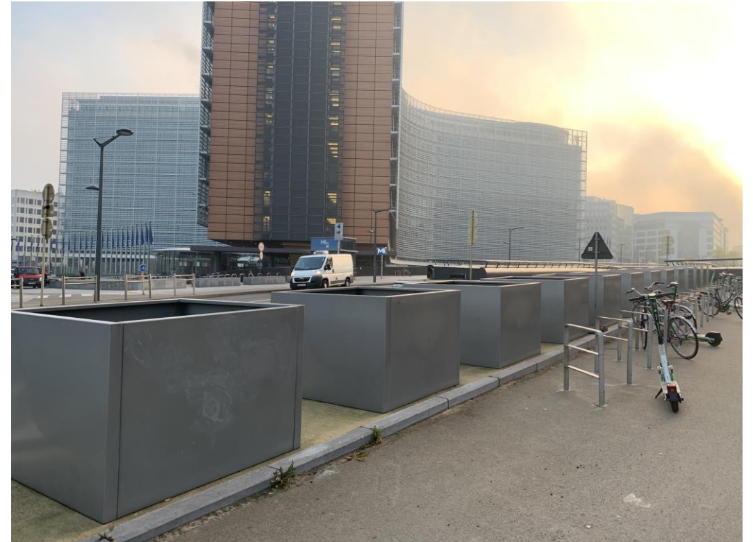
Immeuble Europa, 2021 Blocs, piétonniers encombrés, bâtiment
