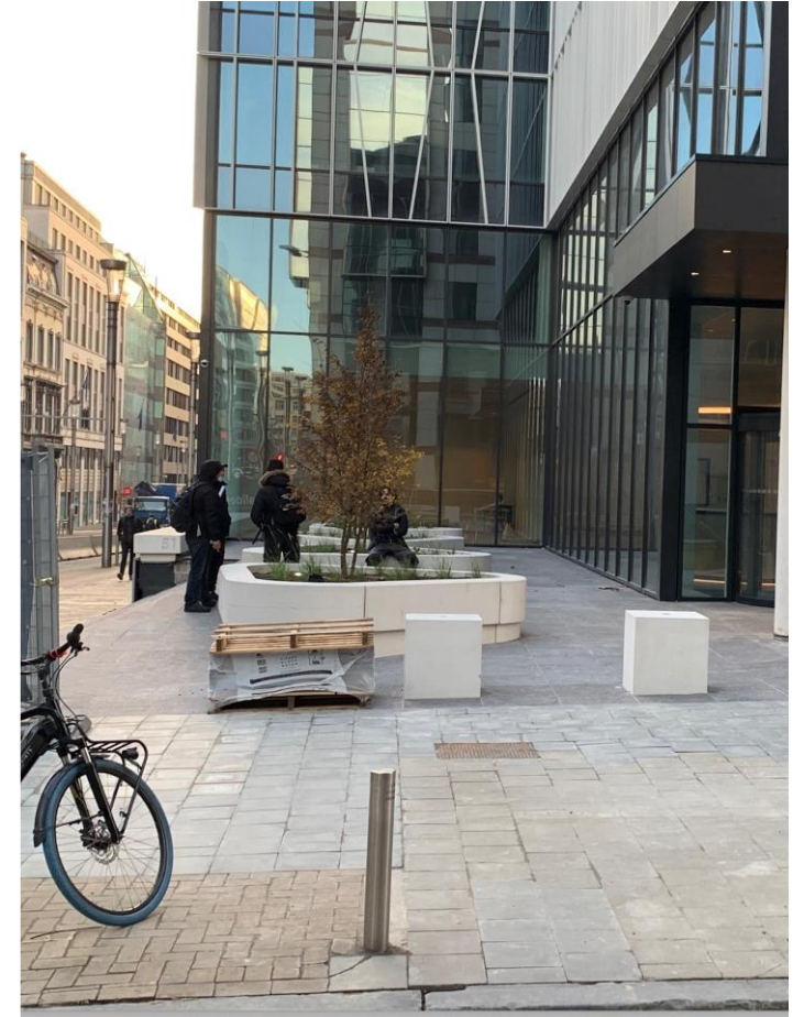
Immeuble Alides, LD2, 2021
